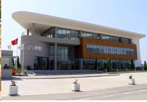
İHH Bursa Afet Koordinasyon Merkezi
